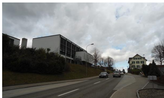
Bremgartenstrasse Blickrichtung Norden
